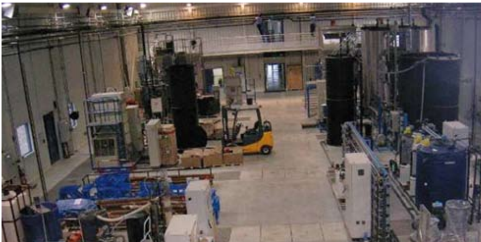
Halle d'essais d'Annet-sur-Marne
